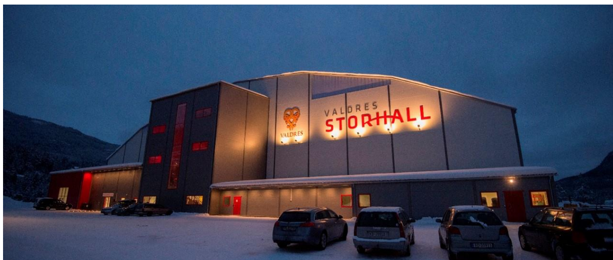
VALDRES STORHALL Bilde: www.valdresstorhall.no
