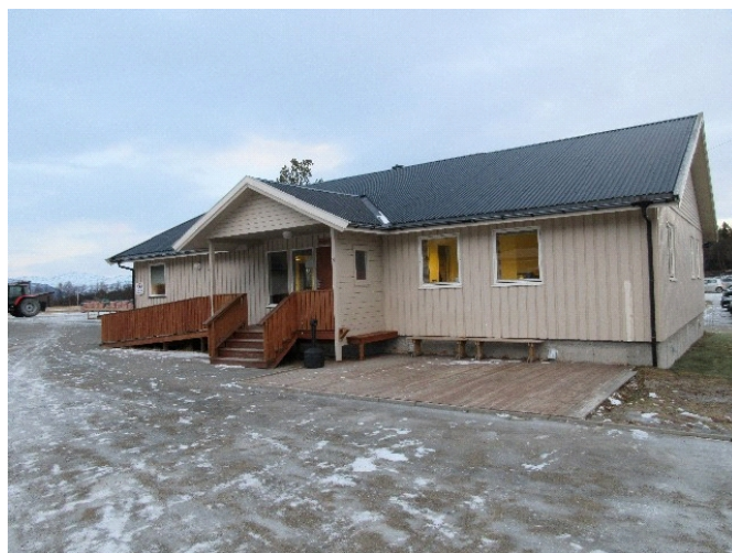
Overbygd inngangsparti med rullestol rampe.
