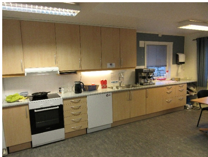
Kantine med ny kjøkkeninnredning.
