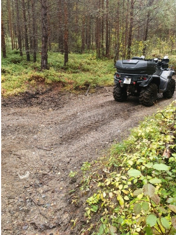
Figur 3. Statnett har gravd grøfter på tvers av veien for å lede overvann ut i terrenget. Foto: NVE
