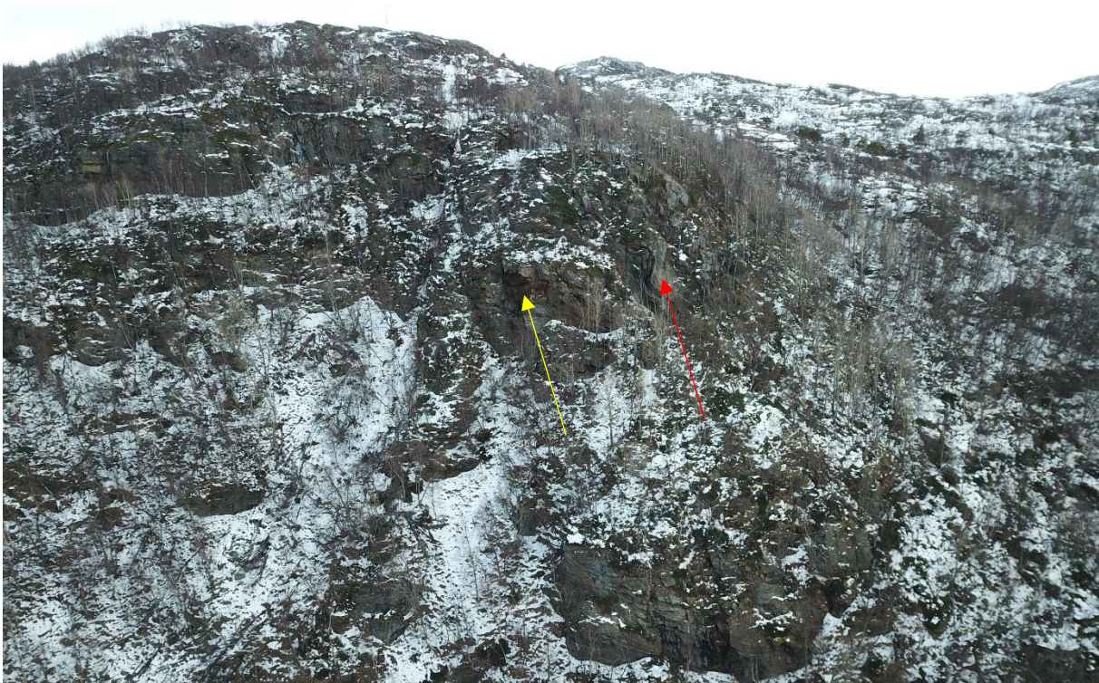
Figur 13: Nåværende forhold ved kildeområdet til steinspranget 17. mai 2021 (gul pil). Rød pil viser foldede sprekker.
