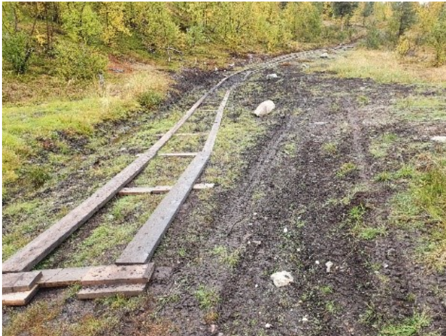
Figur 2. Kloppingen over myra er ikke tilstrekkelig for at myra får sette seg. Foto: NVE
