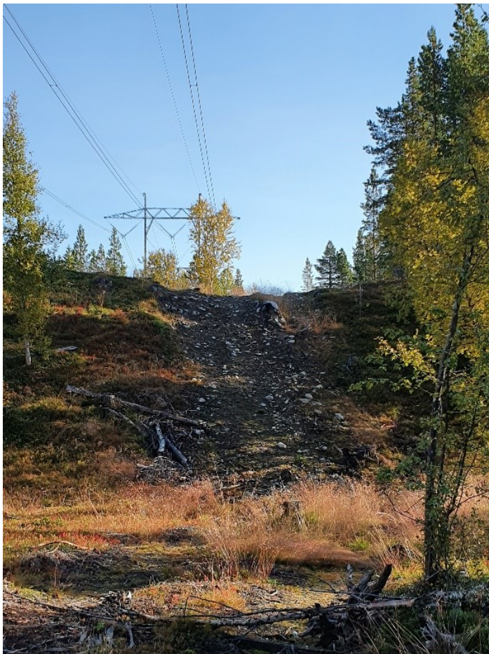
Figur 25. Hogstmaskinvei Vangen TK147be er tilbakeført. Godt med vekstmasser tilsier at veien vil bli revegetert innen kort tid. Foto: NVE
