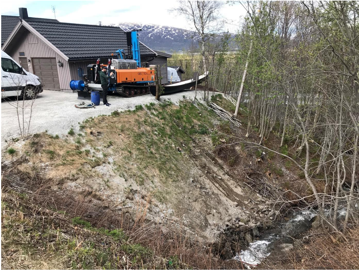
Utføring av grunnundersøkelser mellom garasje og bekkeleiet. Foto: Arktisk Geotek AS.
