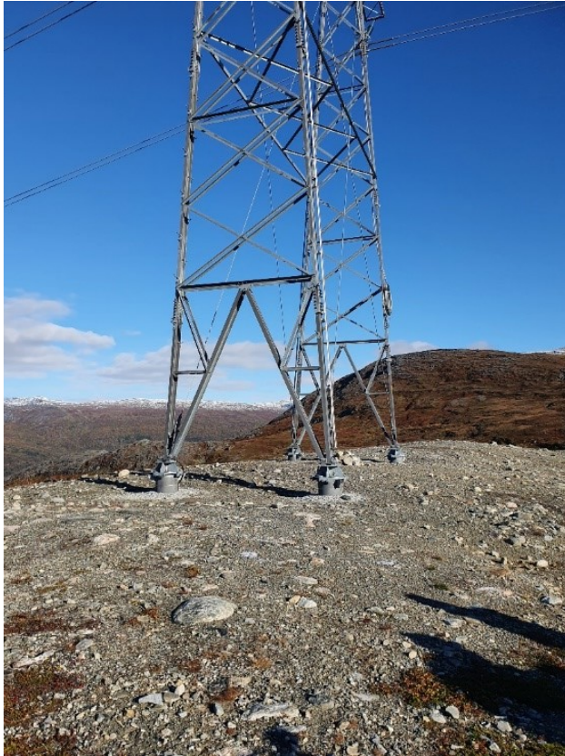
Figur 16. BM362. Eksponert og karrig mastepunkt på Gahperus som er vanskelig å revegetere. Vegetasjonen kryper sakte men sikkert inn fra kantene, men dette vil ta tid. Foto: NVE
