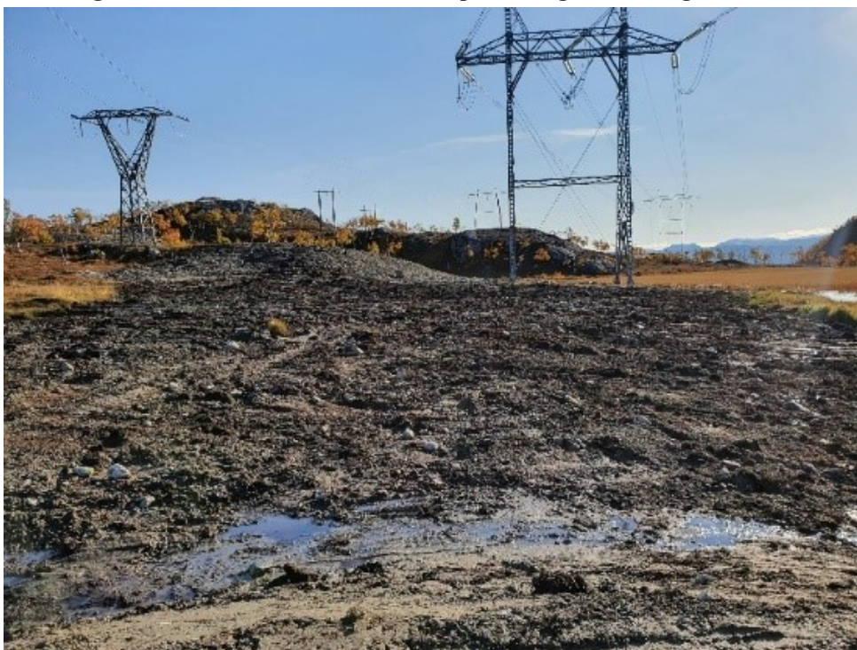
Figur 19. B65-BM495. Godt tilbakeført baseplass og mastepunkt med god terrengforming. Foto: NVE
