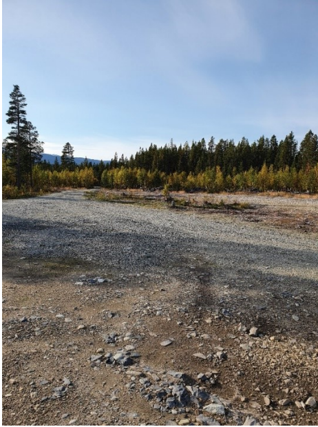
Figur 30. Helikopterlandingsplass 374. Plassen skal tilbakeføres til en rundkjøring ved at hogstavfall dras inn og flata rufses til. Statnett gjør dette etter instruks fra grunneier Statskog. Foto: NVE
