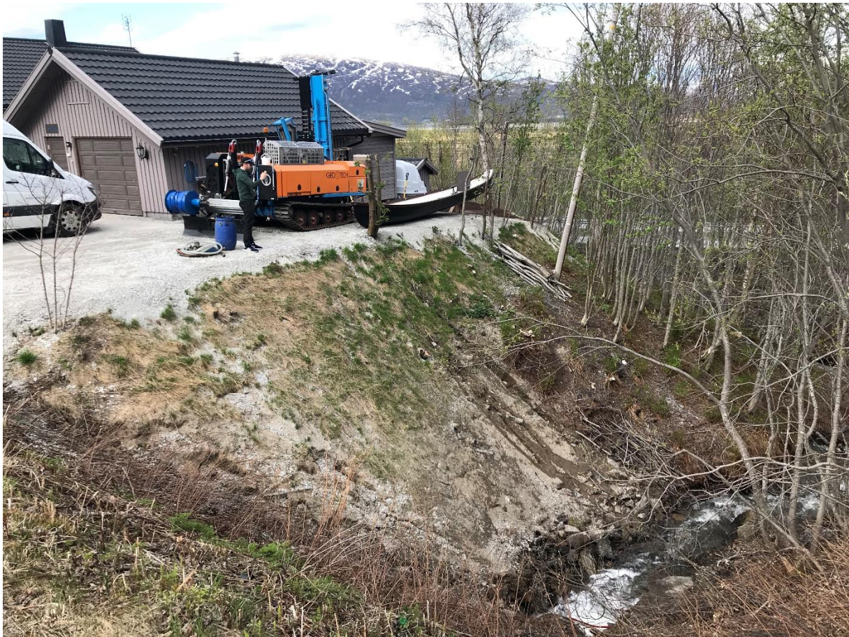
Figur 3: Foto av garasje og skråning ned mot bekk. Foto: Arktisk Geotek AS.
