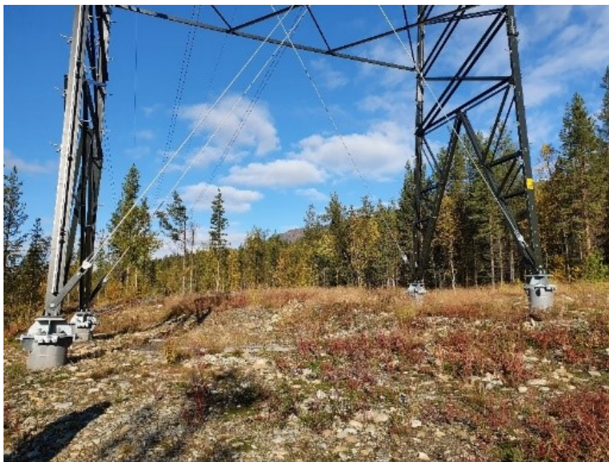
Figur 11. BM381. Mastepunktet var tørt og ble forsøkt sådd, med dårlig resultat. Det viser seg at den lokale frøbanken har klart seg bedre enn fryktet og punktet er på god vei til å bli naturlig revegetert. Foto: NVE
