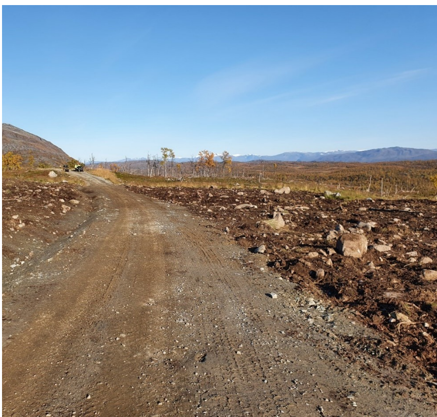
Figur 23. Baseplass B64. God istandsetting. Litt mye stein i dagen, men fordi det er mye stein i jordmonnet er det ikke til å unngå. Foto: NVE
