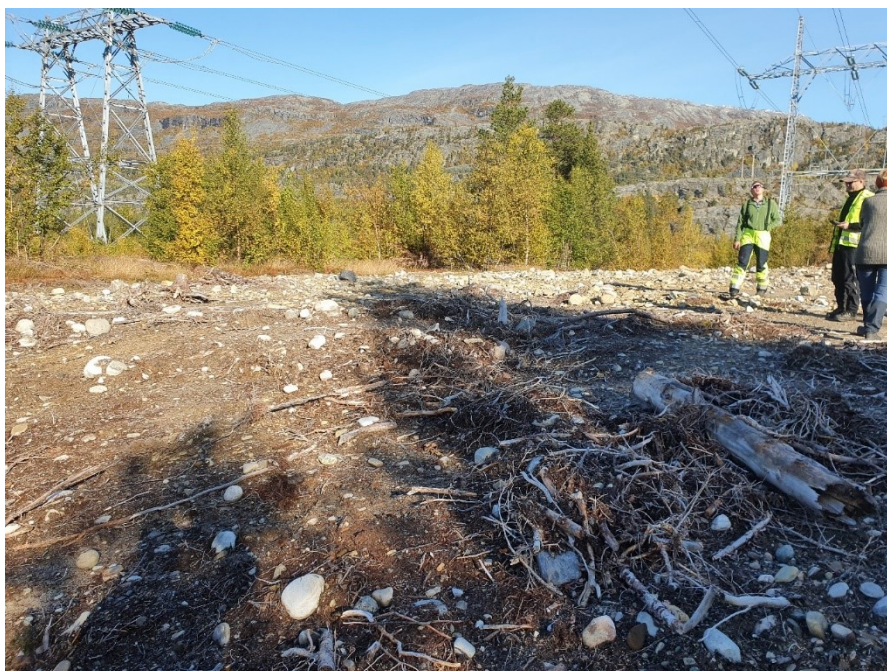
Figur 27. Strekkeklassen er delvis tilbakeført, men hogstavfall og vekstmasser er veltet ut i bekkedalen utenfor bildet. Plassen er skrinn, og all tilgjengelig vekstmasse har stor verdi for sluttresultatet. Disse massene skal trekkes opp igjen og brukes i arronderingen.
