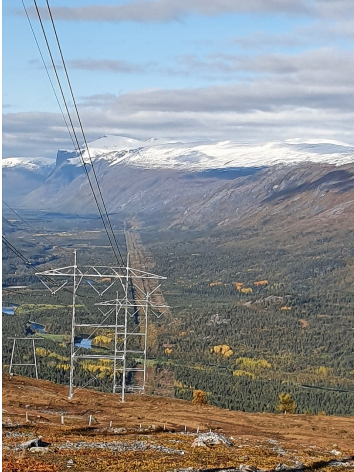
Figur 18. Utsikt fra Gahperus og nedover Reisadalen (420 kV t.h.). Det er utført skånsom skogrydding slik at ledningstraseen har fått noe bedre landskapsvirkning enn ledningstraseen t.v. Foto: NVE
