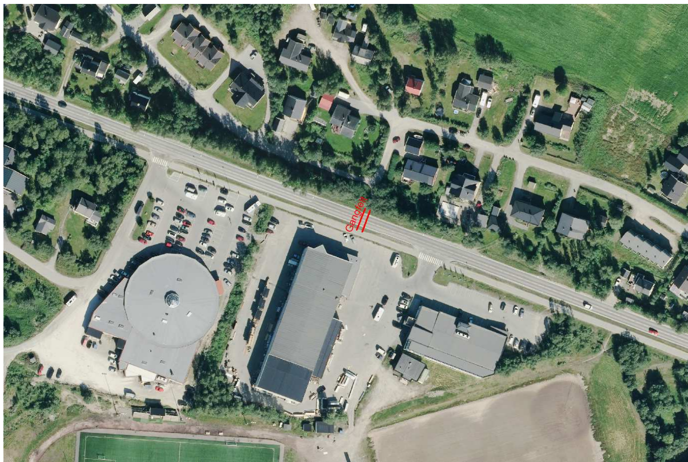
Nr 8 E6 - gangfelt ved Montér byggevarerhus
