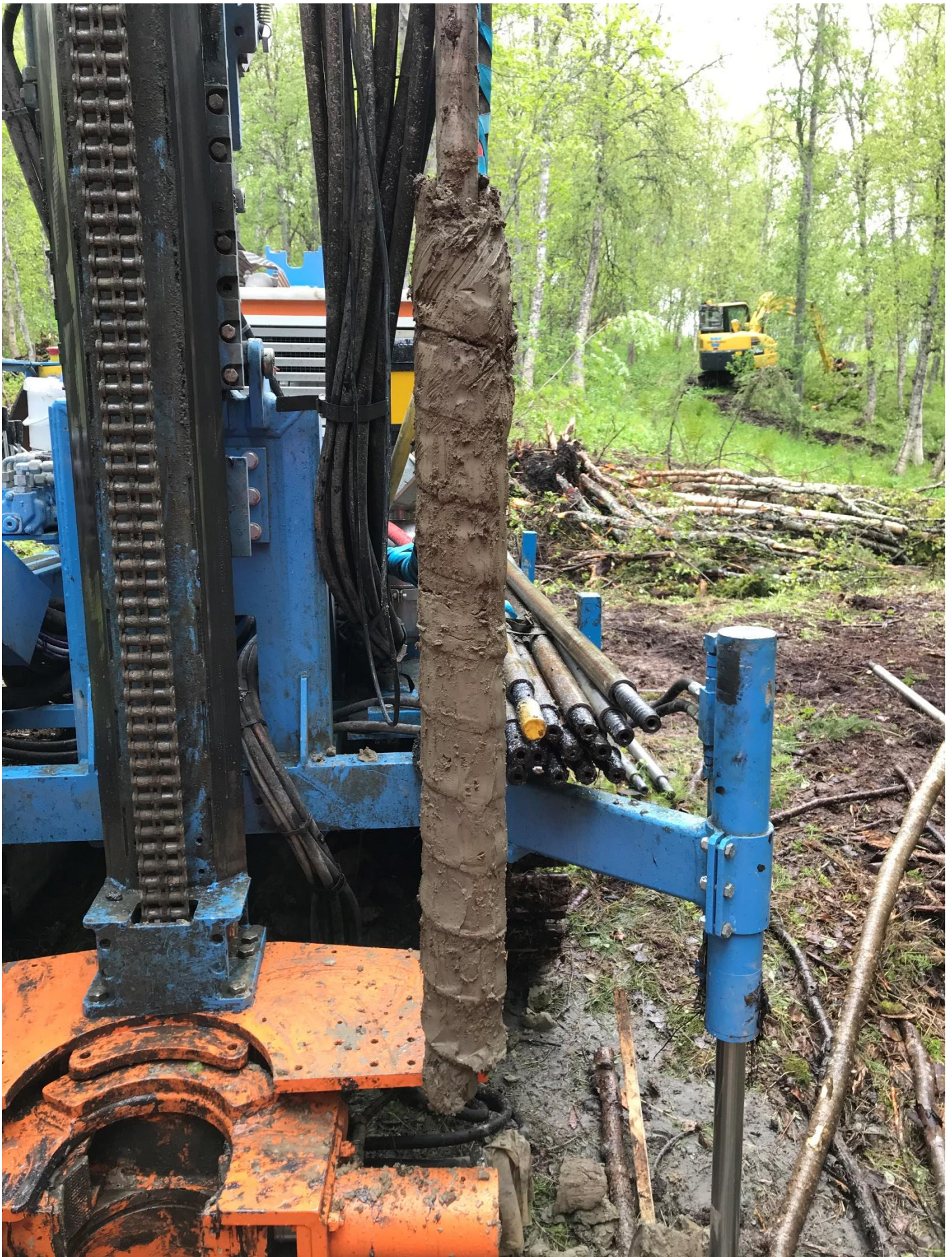
Naverboring fra B4 mellom 2-3 meters dybde under terreng
