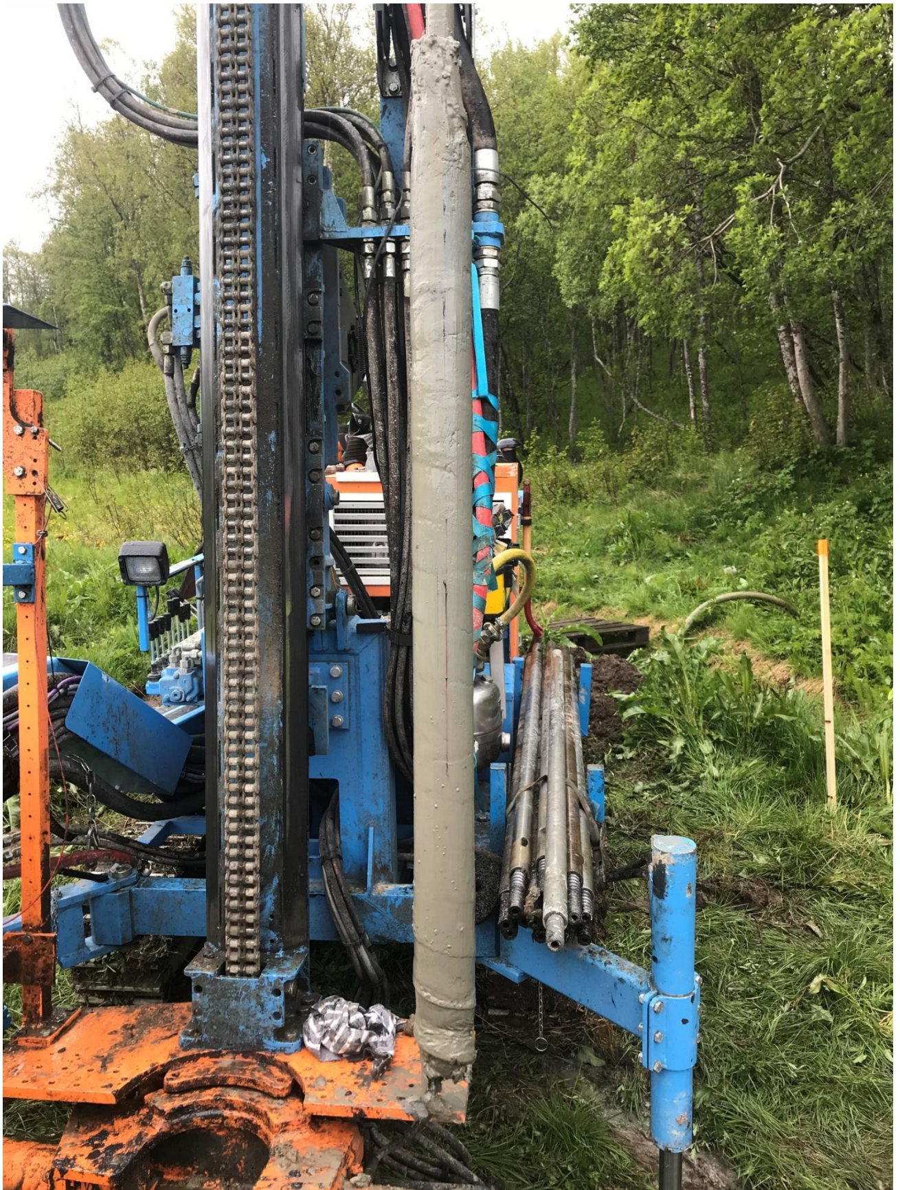
Naverboring fra B6 mellom 4-5 meters dybde under terreng
