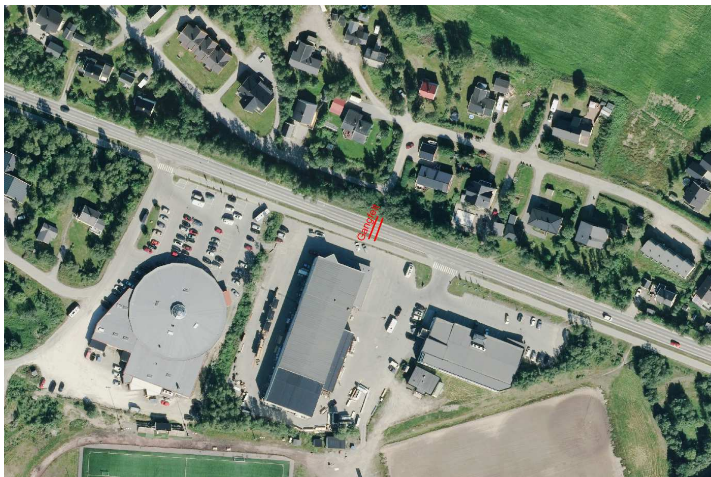
Nr 8 E6 - gangfelt ved Montér byggevarehus
