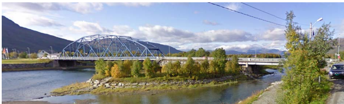
Figur 1 Dagens fagverksbru og bjelkebru
