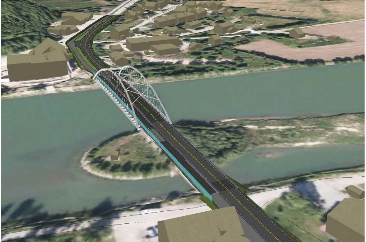
Figur 4 Den nye brua
