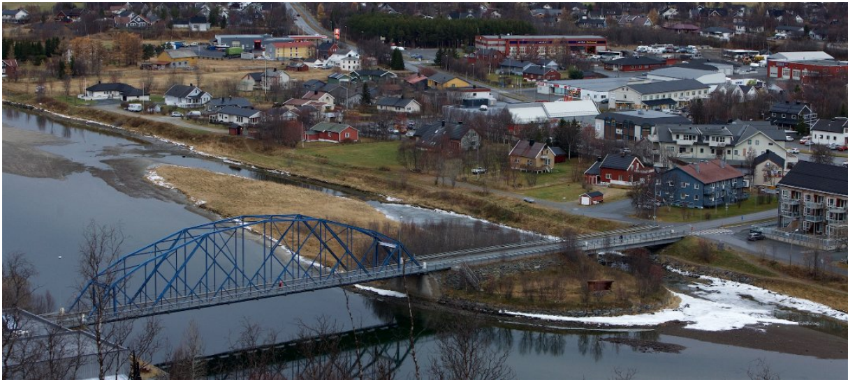
Figur 1 Dagens fagverksbru og bjelkebru over Reisaelva, foto Nordlys/Ola Solvang
