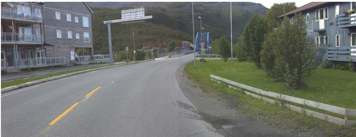
Figur 26 Østsida av brua, Strandvegen 24 «Sanitetshuset» til høyre, og Sentrum 1, Elveland boligpark, til venstre
