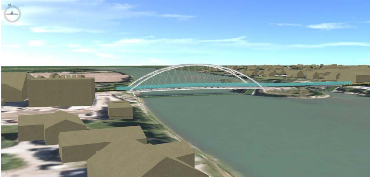
Figur 8 Nettverksbuebru, illustrasjon: ÅF Engineering
