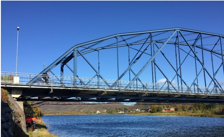
Figur 19 Dagens fagverksbru over Reisaelva
