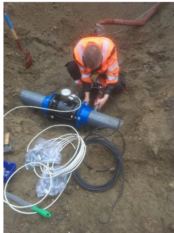
Montering av sonevannmåler.
