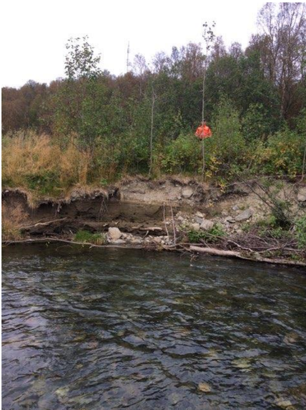
Kritisk utgraving langs Krakenesveien
