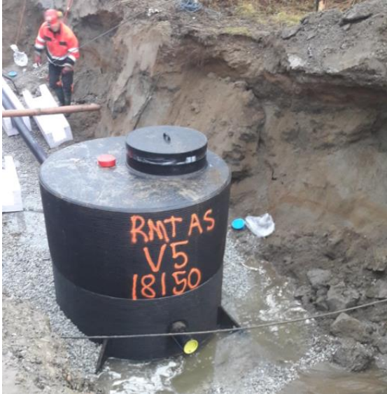
Legging av ny vannledning i Sørkjosen
