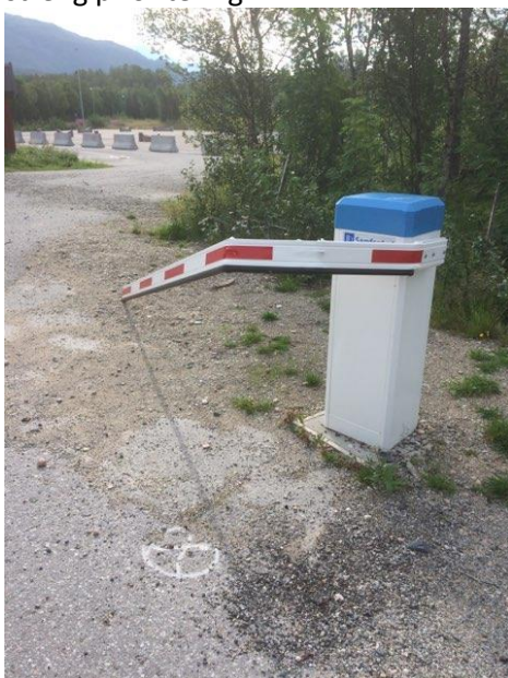
Hærverk på bom langs gangvei til skole.
