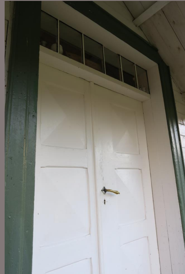
Dobbeltfløyet inngangsdør med overlysvindu
