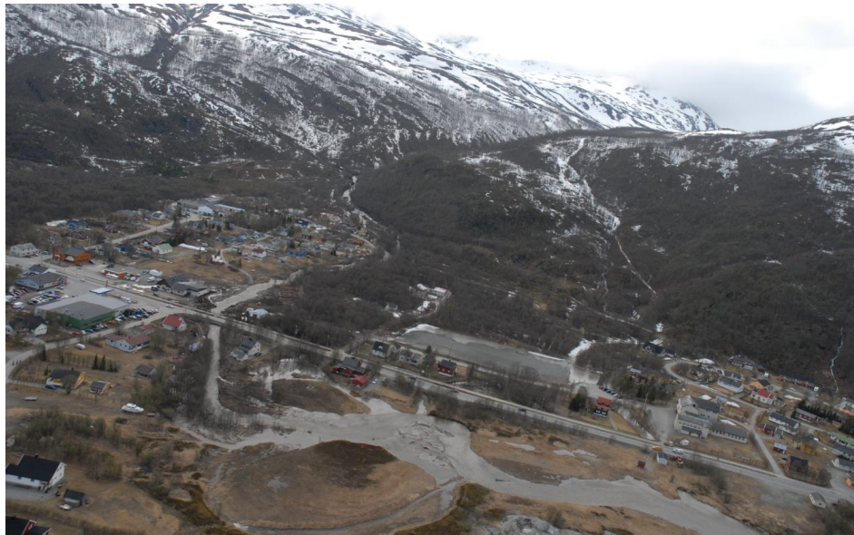
Figur 10: Oversiktsbilde fra helikopter over Jernelva motstrøms. Bilde tatt like etter flom i 2010. Bilde viser oversikt over byggeområde 1,2,3 og 4. Foto: NVE.
