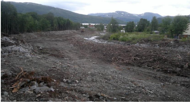
Figur 12: Utarbeidet flomsikringstiltak i 2011 med et løp for lavvannføring og is, og et løp for å kunne ta i mot stor flom og massetransport. Foto: NVE.
