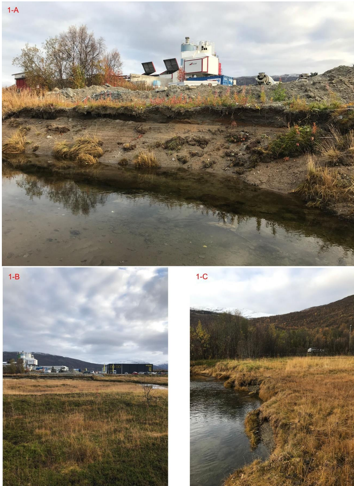
Figur 4: Bildeposisjoner er markert i figur 2. (1-A) skråningshøyde retning øst for Jernelva mellom Mekonomen og Betongservice. Tilførte fyllmasser oppå torvdekke dernest dominerende elvesand og grus. Litt erosjon som medfører periodevis lokale utglidninger av torvdekket og friksjonsmasser. (1-B) Terrenget sett fra vestsiden av Jernelva. Dominerende lyng i øvre del med en gradvis overgang til gressbelagt torvdekke i nedre del ved elva. (1-C) Sett mot E6 fra vestsiden av Jernelva. Jernelva tar en sving i dette punktet og vurderes som litt eroderende. Foto: Arktisk Geotek AS.
