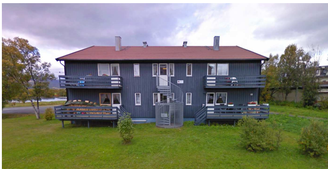
Figur 5-2: Bygning 15/31 i rød sone
