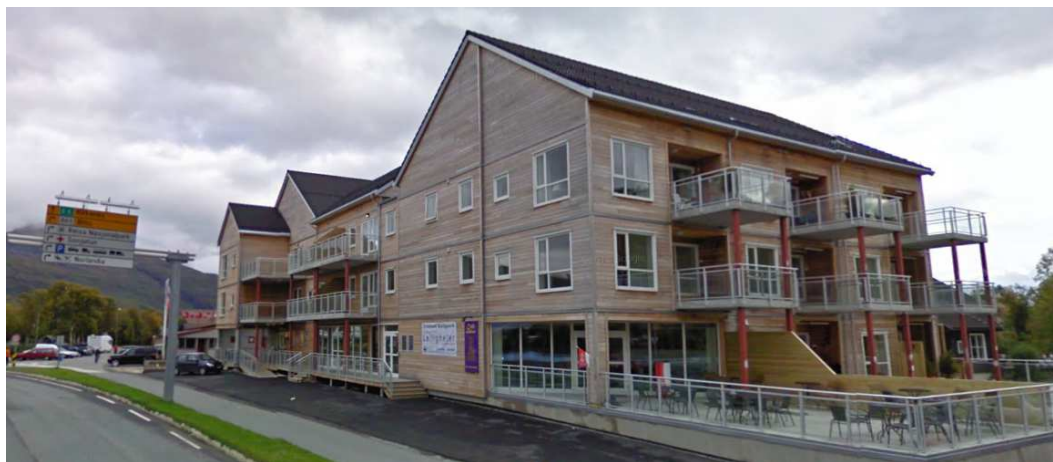
Figur 5-2: Bygning 15/51 i rød sone
