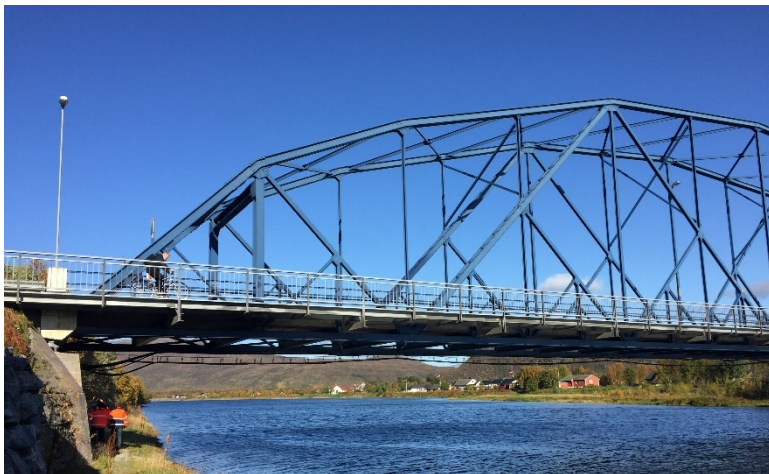
Figur 20 Dagens fagverksbru over Reisaelva
