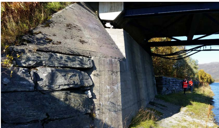
Figur 22 Passasje under dagens bru på vestsida
