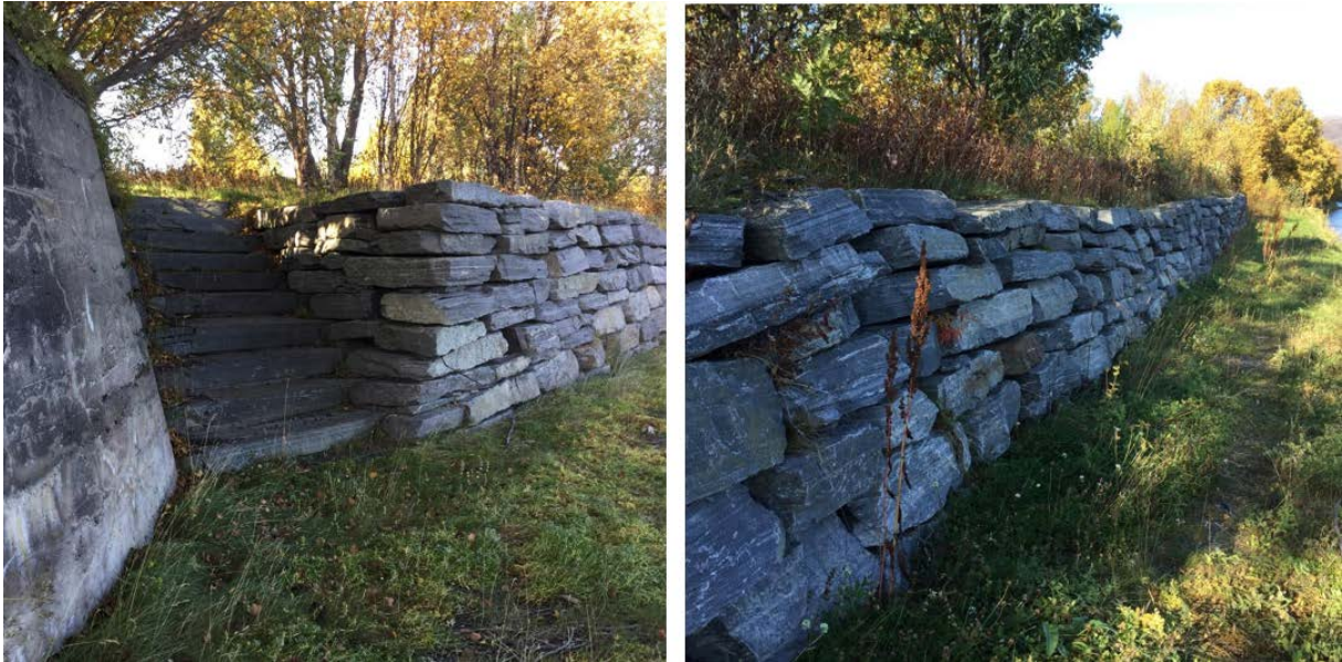
Figur 24 Trapp og mur i forbygninga, like nord for brufundament.
