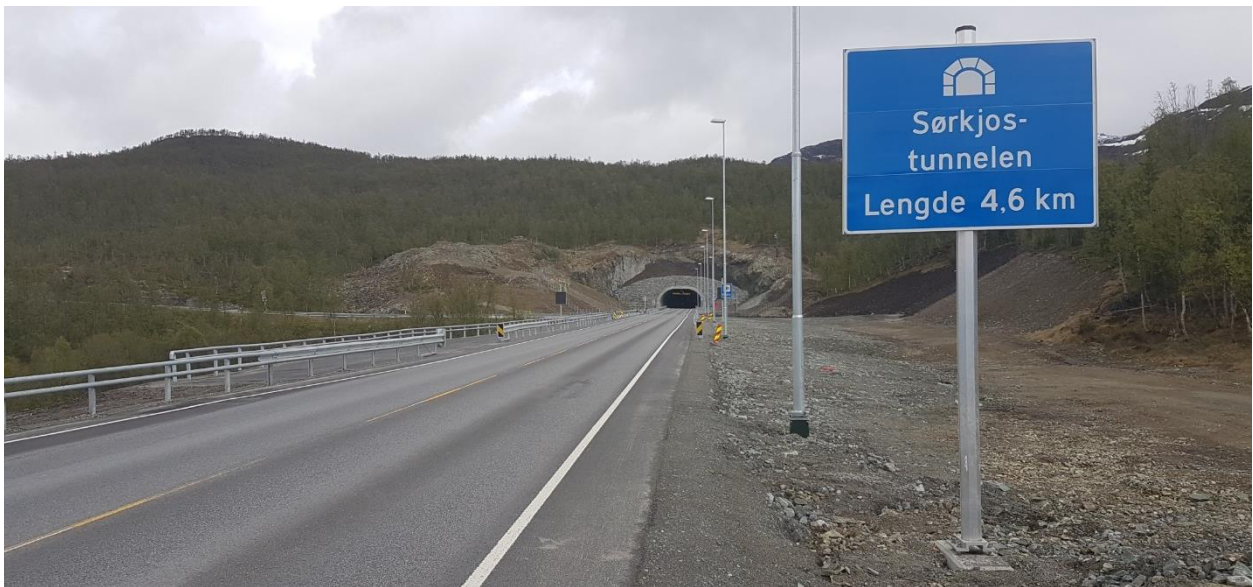
Bilde 4-1: Sørkjostunnelen åpnet 2. februar 2018 (Foto: Transportutvikling, 2018)
