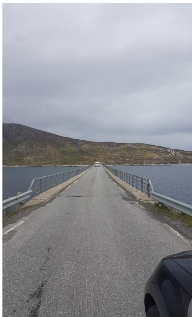
Bilde 4-2: Skjervøybrua, FV866 (Foto: Transportutvikling AS, okt. 2018)
