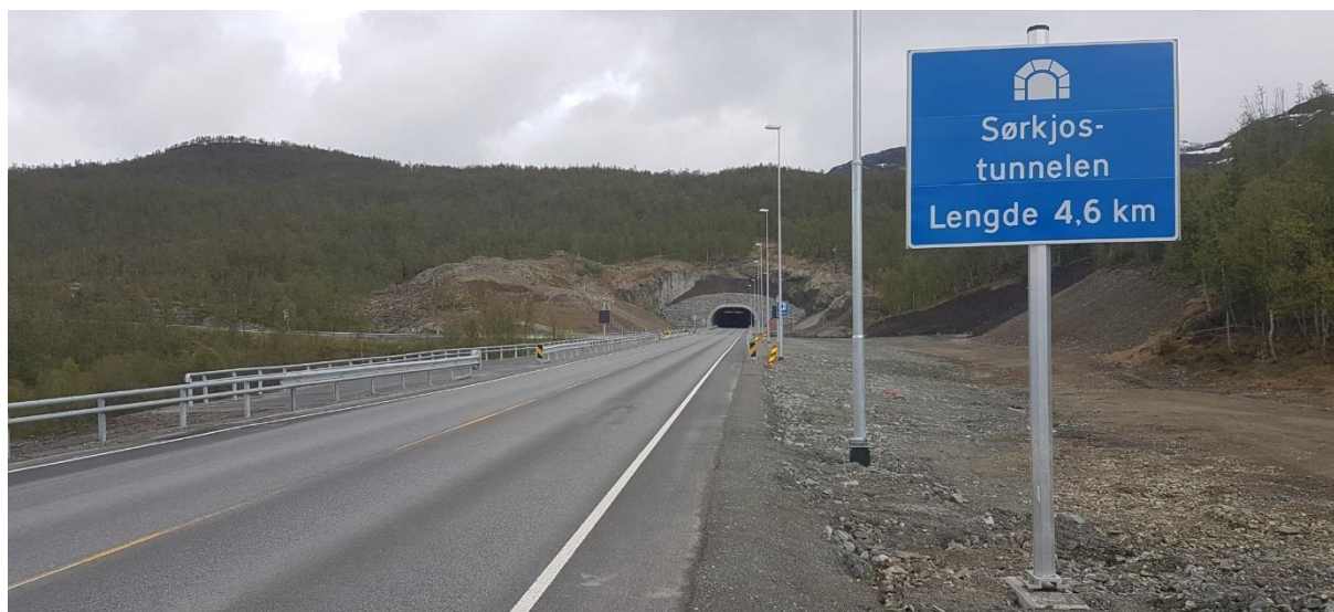
Sørkjostunnelen (Foto: Transportutvikling AS)
