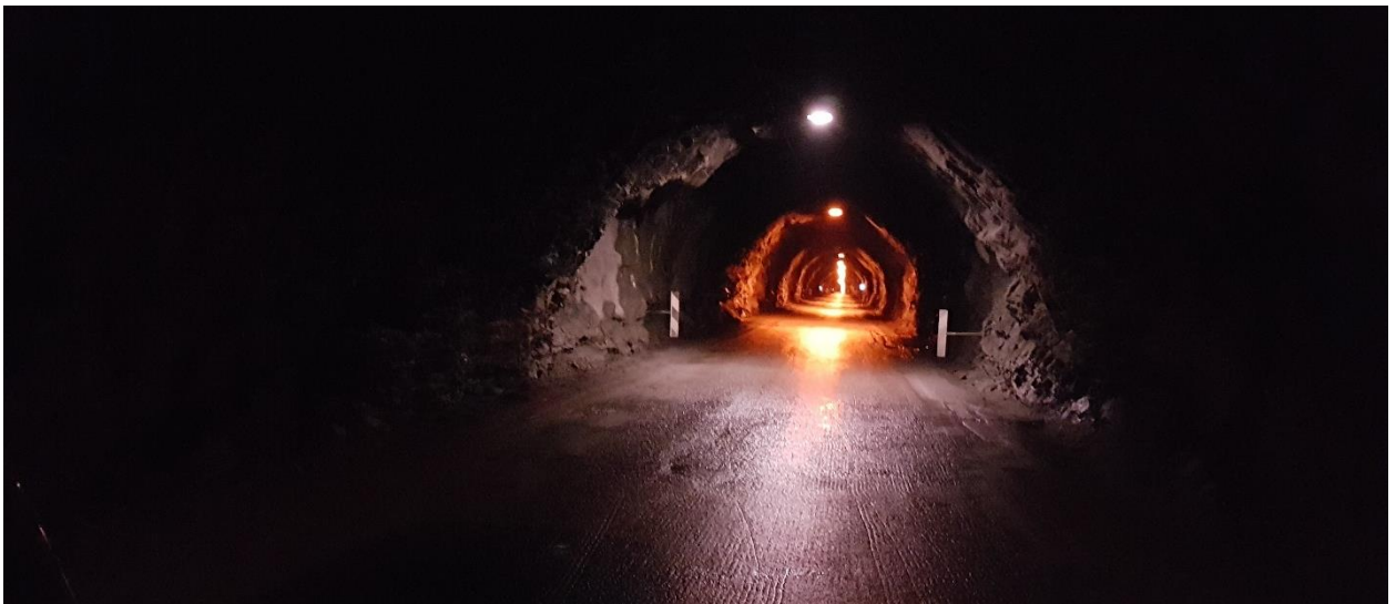
Pollfjelltunnelen på FV868 (Foto: Transportutvikling AS, 2018)
