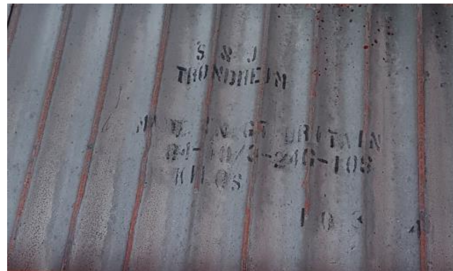
Blikktaket og takstolene på sørsiden (påbygget). Skriften på blikktaket avdekker produksjon i Storbritannia og eksport til Trondheim, mest sannsynlig rett etter krigen.
