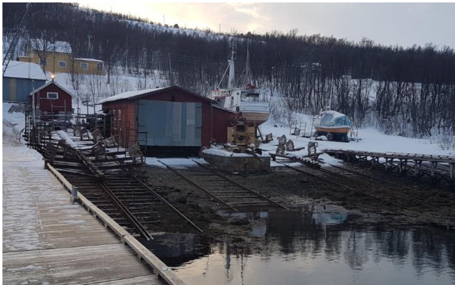
I følge Helge Olsen var den første slippet laget av tømmerstokker. I siste kvartal av 1900-tallet ble stakkene erstattet av jernskinner som brukes også i dag.
