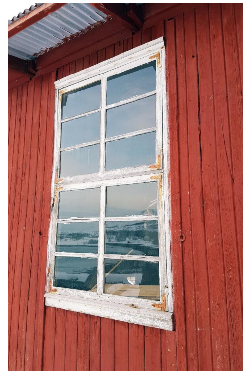
Langsiden mot sør. Opprinnelig vindu og panel og blikktak fra 1950-tallet.
