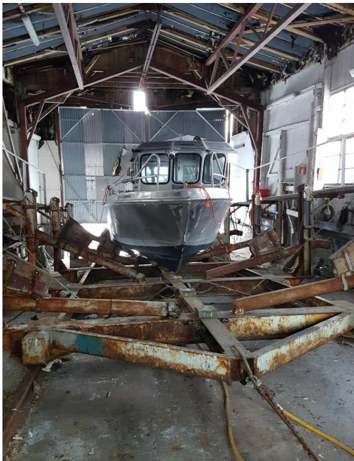
Taket og veggene er forsterket med metallbjelker og pilarer.
