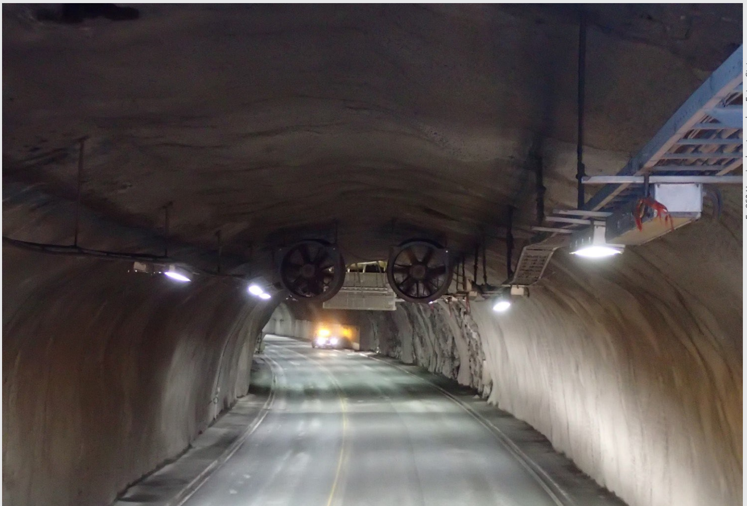
Fv 862 Hansjordnestunnelen. Foto: Statens vegvesen
