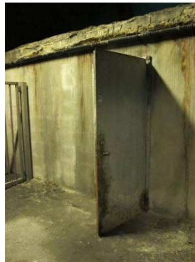
Teknisk bygg lbestadtunnelen. Foto: SVV
