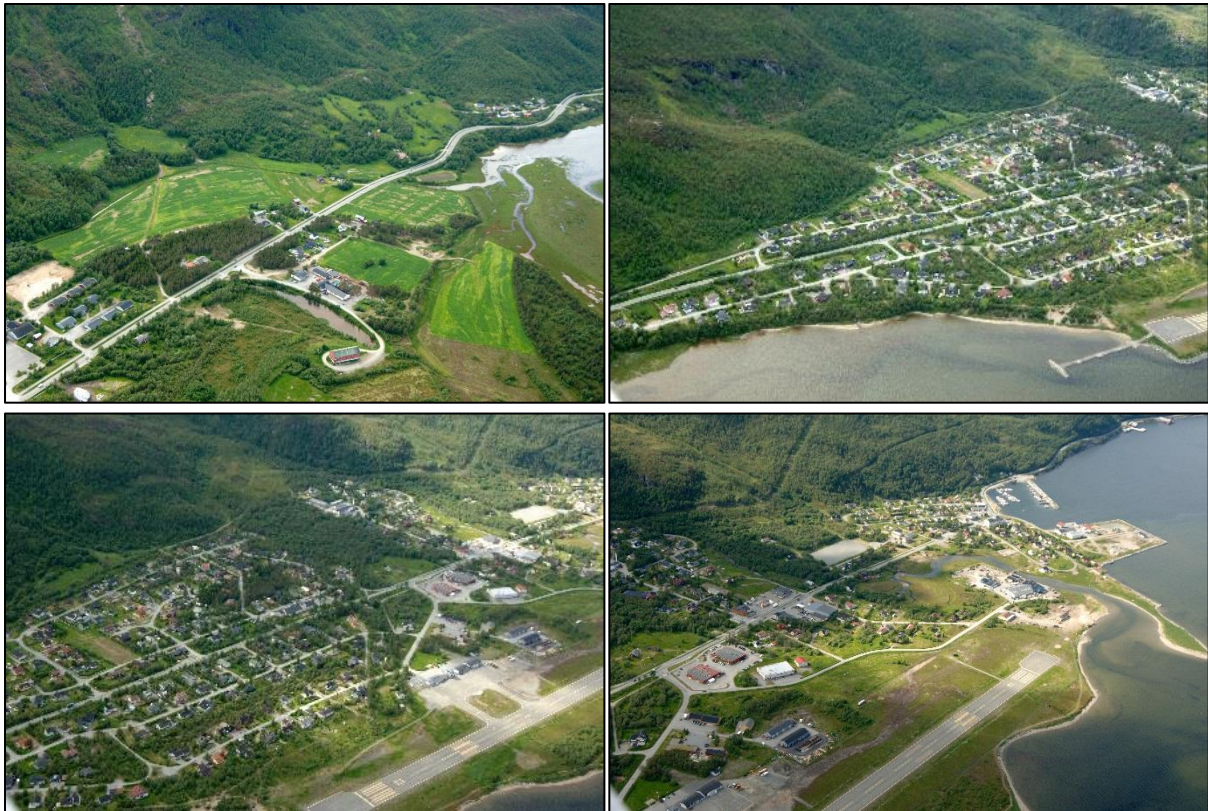
Figur 6: Skråfoto fra planområdet. Oppe til venstre: Planområdet starter oppe i høyrehjørne der et lite boligfelt skimtes og strekker seg videre ut av bildet. Oppe til høyre: Området fra Leirbuktsvingene til Goppa. I hovedsak boligbebyggelse, samt noe næring. Nede til venstre: Mye likt forrige bilde, men her ser man også bygningene på flyplassen samt endel av eksisterende næringsarealer. Nede til høyre: Viser videre fra Flyplasskrysset og ned til Sørkjosen havn.
