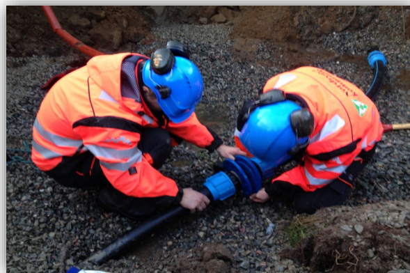
Arbeid på vannledning.
