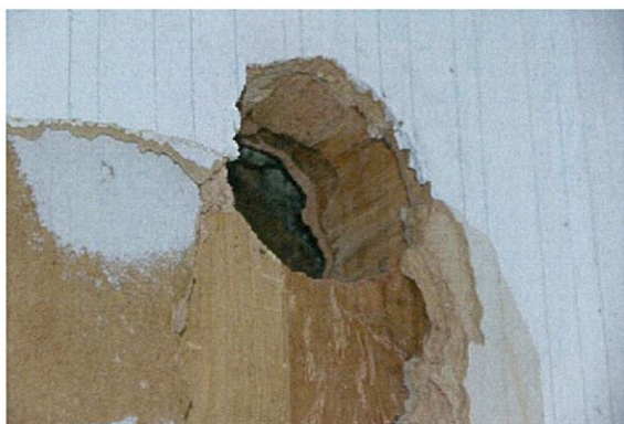
Snitt gjennom plankevegg
