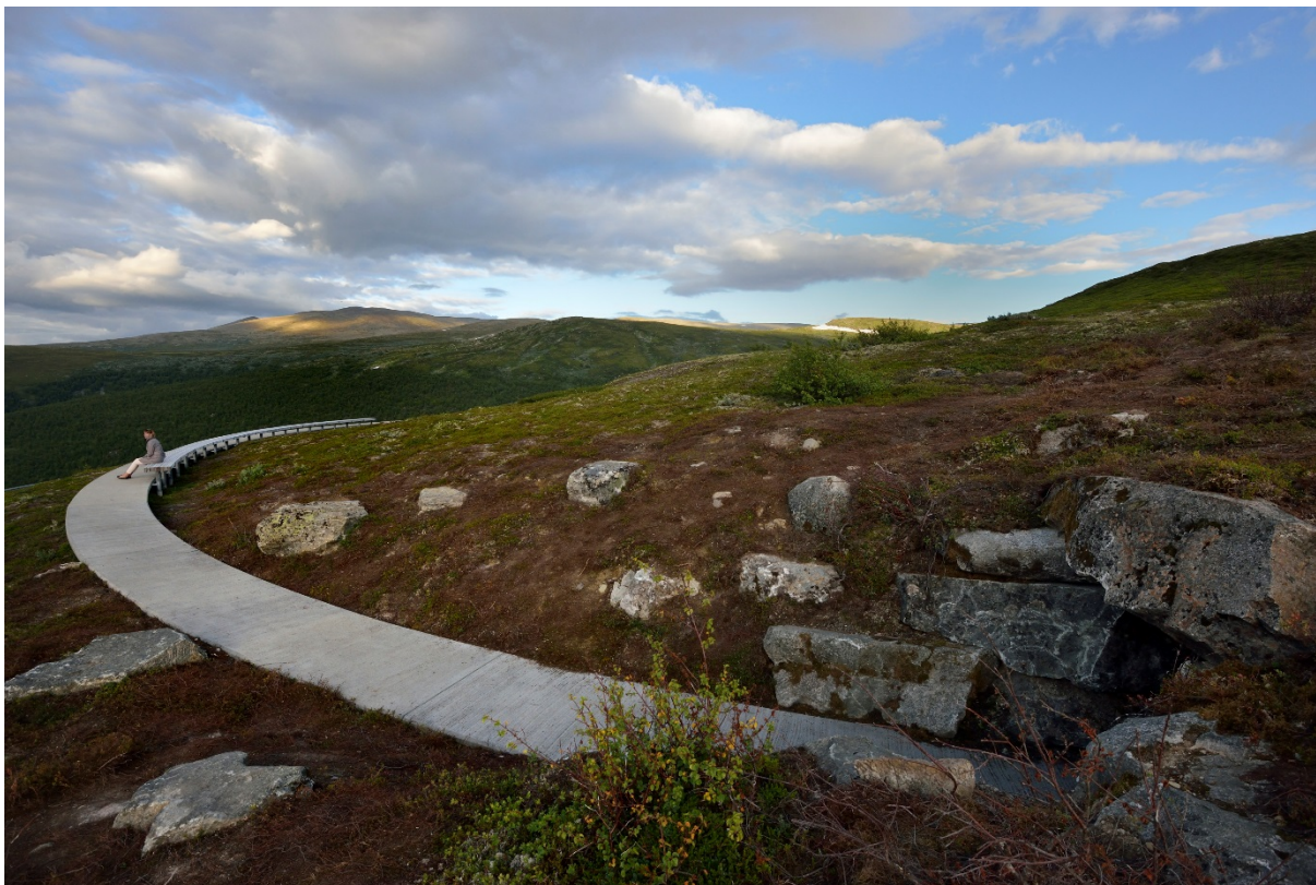
Figur 21) Foto: Vedahaugane på fjellvegen mellom Lærdal og Aurland. Et tydelig, men nøkternt, arkitektonisk grep i samspill med terreng og eksisterende sårbar fjellvegetasjon. Foto: Roger Ellingsen, Statens vegvesen.
