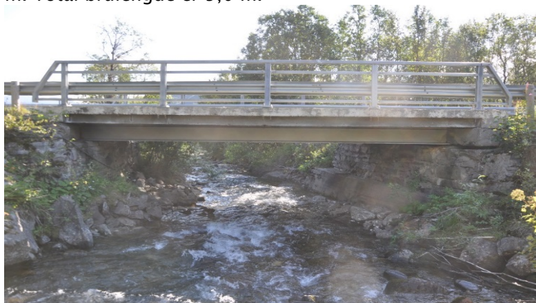
Figur 4) Foto: Sjutselva bru
