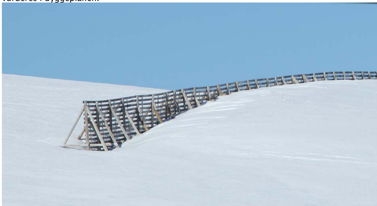
Figur 25) Foto: Snøskjerm på Kvænangsfjellet
