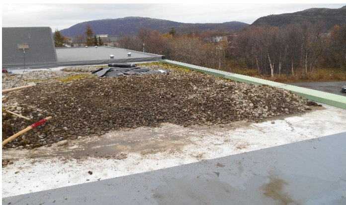
Utskifting av takmembran på kommunehuset.
